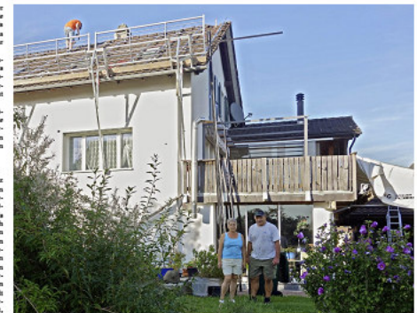
Visionen für die Zukunft: Die Familie Stark lässt eine Photovoltaik-Anlage mit Stromspeicher auf dem Dach ihres Hauses installieren, damit sie einen grossen Teil des Energieverbrauchs mit Eigenproduktion decken kann.
