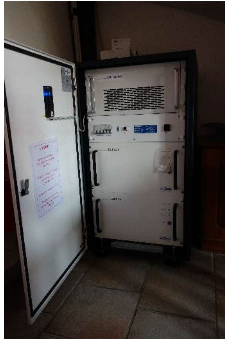
Lithium Stromspeicher mit einer 10 kWh Kapazität
