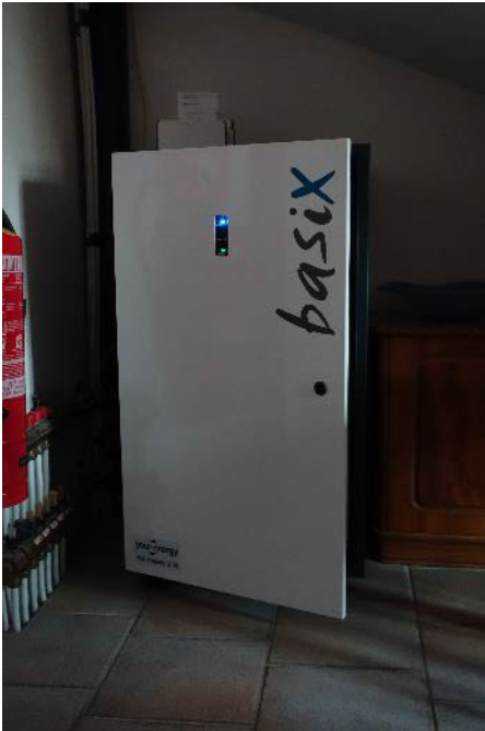
Lithium Stromspeicher mit einer 10 kWh Kapazität
